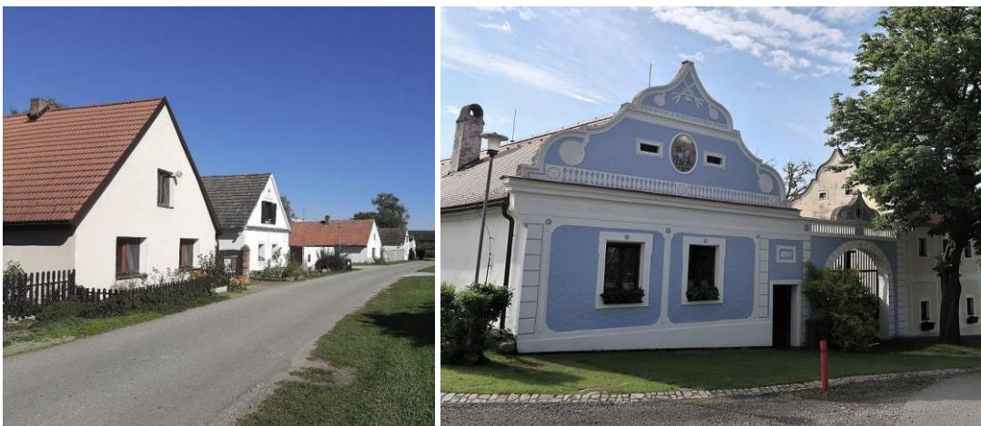
Příklady přesahů střechy u štítové stěny na domech v Plástovicích – přesahy minimální, hřeben a střecha často kryty štítovou stěnou.
