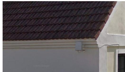
Příklad okapní římsy na domě v Plástovicích – přesah minimální, římsa omítaná, profilace.
