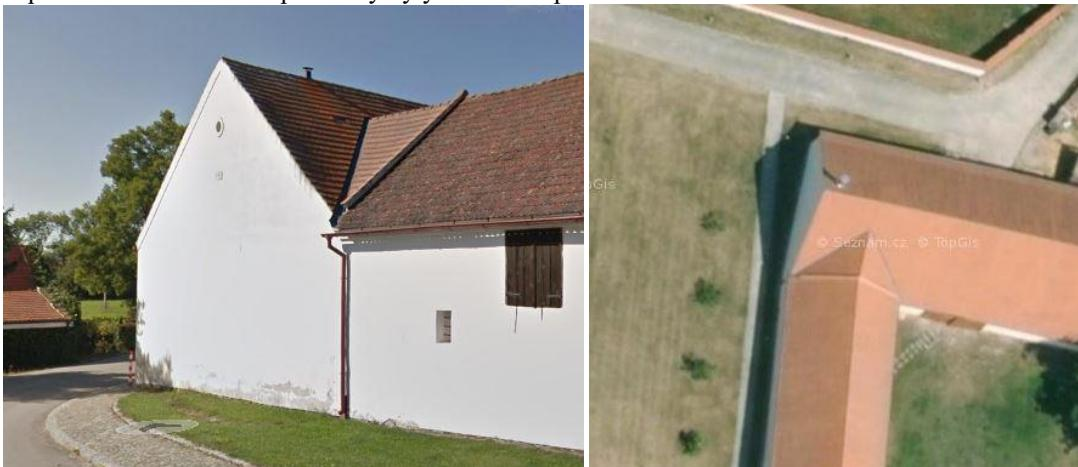
Příklady řešení styku dvou střech propsáním štítu na fasádě na domech v Plástovicích.
